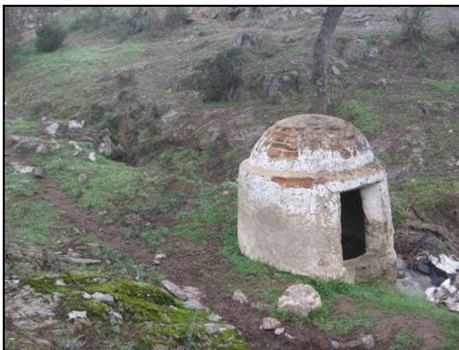
Figura 4.12.54 - Vista geral para o poço de Monte Rochinha 8
