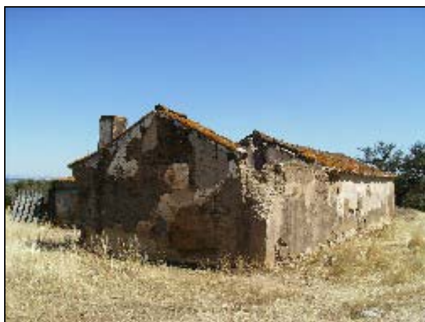
Figura 4.12.45 - Estrutura de apoio agrícola próximo do Monte do Postorinho construída em Taipa
