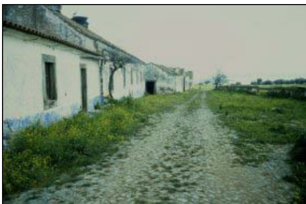
Figura 4.12.64 - Vista para as traseiras do palacete
