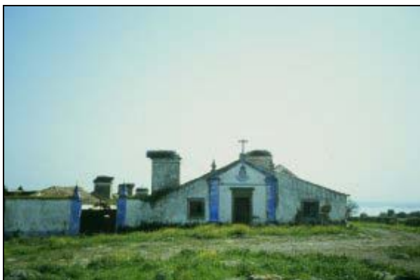
Figura 4.12.62 - Vista da entrada e da capela
